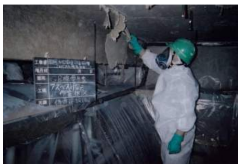
アスベスト除去状況(平成18年度)
