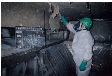
アスベスト除去状況(平成18年度)
