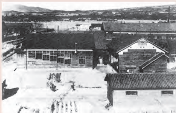
▶1945(昭和20)年に竣工した第2号講堂(医学部の最西南端にあり、現在の刀城会館付近にあつた)
