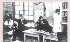
▲初期の学生ホール。木造大講堂を仕切って使用していた=1951(昭和26)年ころ
