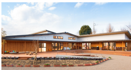
2018年度竣工の附属幼稚園園舎『ZEB』
