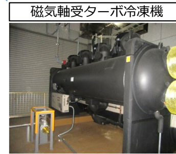
磁気軸受ターボ冷凍機
