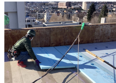
屋根上外断熱材の敷き込み
